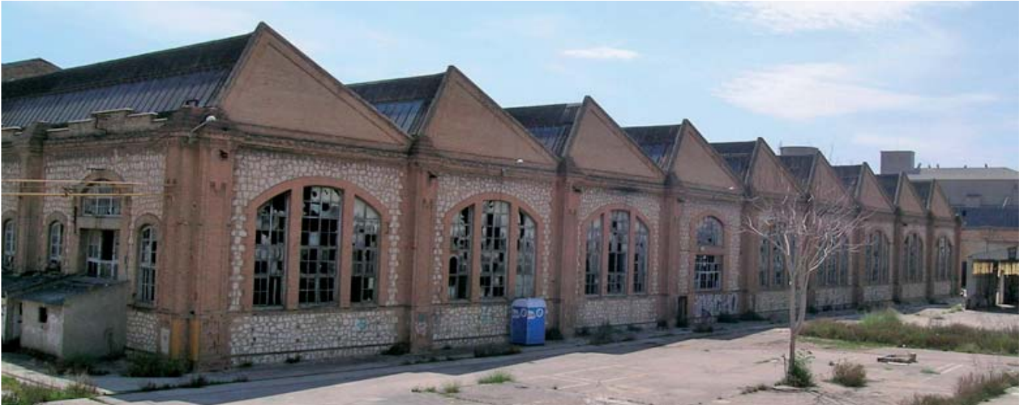
Nave de máquinas a conservar
