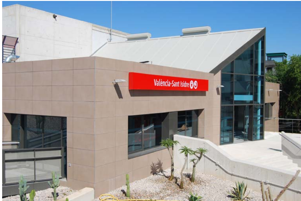
Fachada edificio intercambiador
